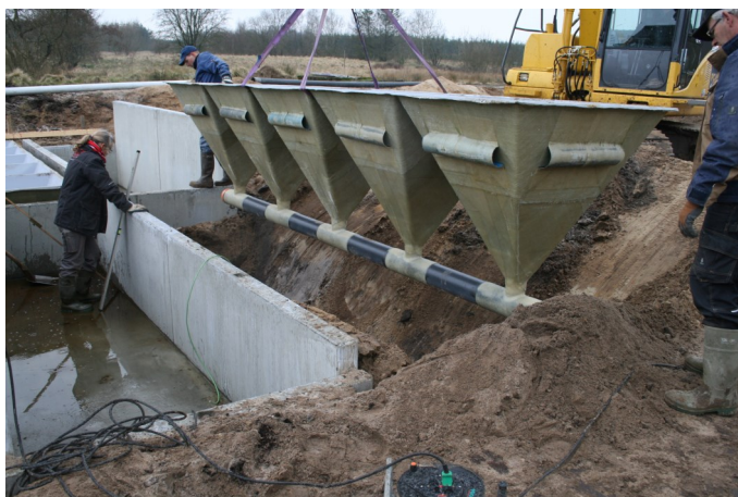
Mynd 5.14. Trektar sem notuð er í landeldi í Danmörku til að safna gruggögnum í lengdarstraumskörum (Ljósmynd: Søren Jøker Trachsel).
