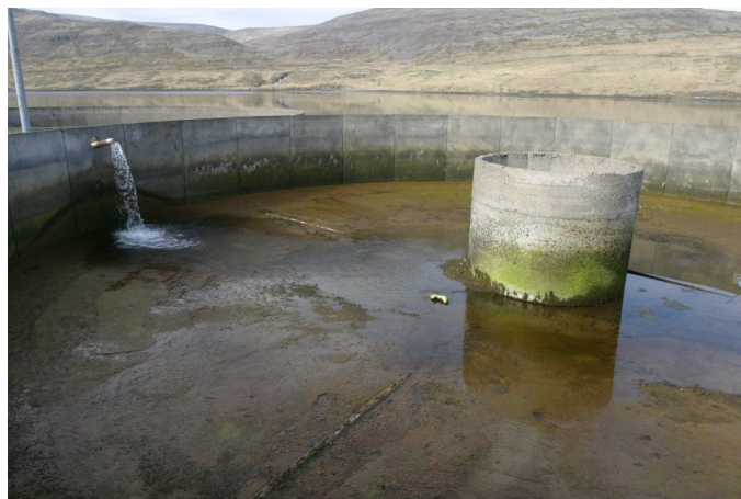
Mynd 5.9. Gamalt kar með stjörnufrárennsli í Bæjarvík í Tálknafirði. Stjörnufrárennslið samanstendur af fjórum vatnslögnum með raufum (Ljósmynd: Valdimar Ingi Gunnarsson).
