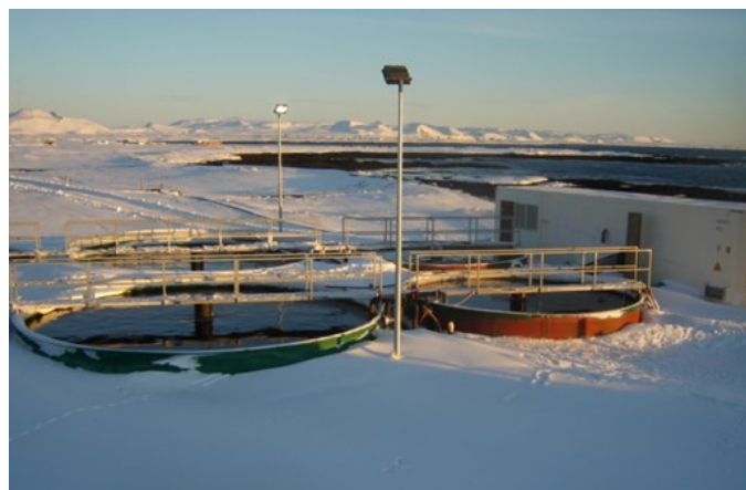
Mynd 2.6. Hreiðrið á Stað við Grindavík. Hér var bleikja alin við 29 ‰ seltu með góðum árangri (ljósmynd: Tómas Árnason).
