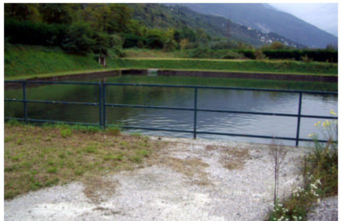
Mynd 52. Setþró fyrir frárennsli (Ljósmynd: Jóhann Geirsson).
