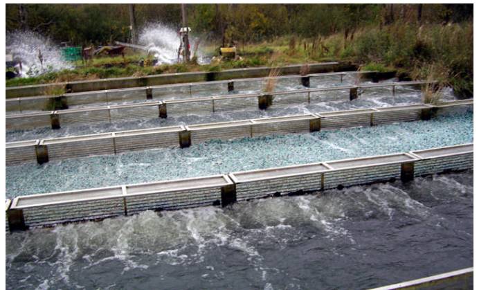
Mynd 29. Lífhreinsir fyrir frárennsli. Efst á myndinni loftun (Ljósmynd: Jóhann Geirsson).
