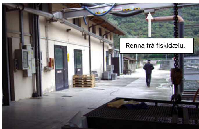
Mynd 57. Fiskvinnsla. Efst á myndinni sjást flutningsrör frá fiskidælu (Ljósmynd: Jóhann Geirsson).
