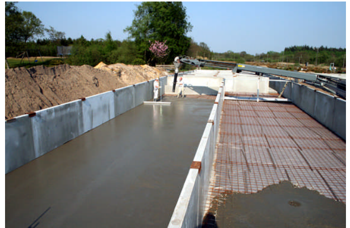
Mynd 5. Botninn steypur (Ljósmynd: Sören Jøker Trachsel).
