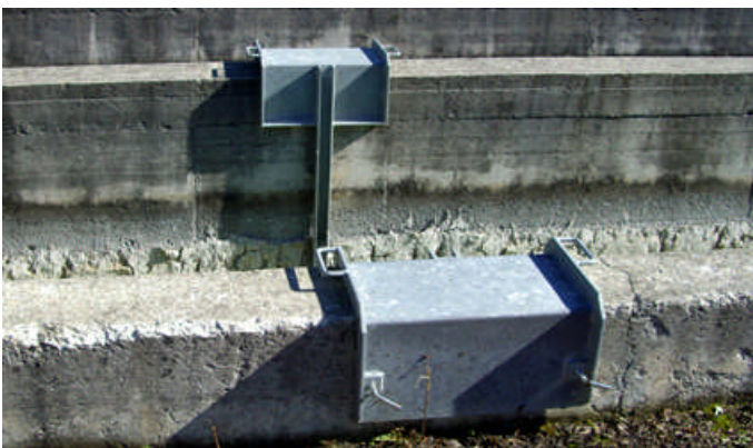
Mynd 50. Færanlegar festingar fyrir grindur til að hólfa niður langkerin (Ljósmynd: Jóhann Geirsson).
