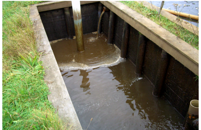
Mynd 28. Setpró fyrir affall frá tromlusíu (Ljósmynd: Jóhann Geirsson).
