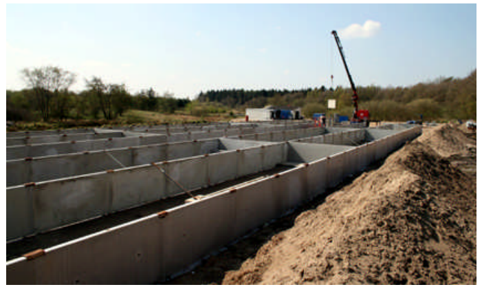
Mynd 4. Nánast búið að setja saman stöð úr forsteypum einingum (Ljósmynd: Sören Jøker Trachsel).
