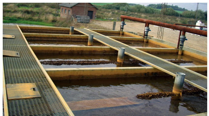
Mynd 33. Járn fjarlægt úr borholuvatni (Ljósmynd: Jóhann Geirsson).
