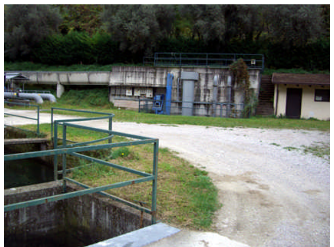
Mynd 53. Dælustöð til endurnýtingar á vatni á álagstímum (Ljósmynd: Jóhann Geirsson).
