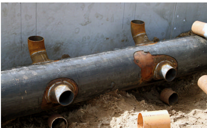
Mynd 10. Stofnlögn fyrir loft og úrtök úr því (Ljósmynd: Sören Jøker Trachsel).
