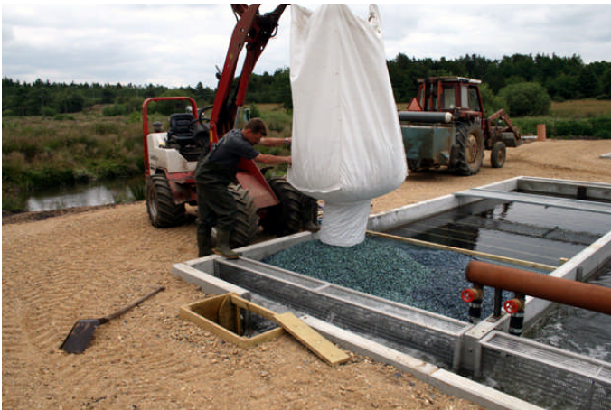
Mynd 16. Past kubbum komið fyrir í fljótandi lífhreinsi (Fluidized-Bed Biofilter) (Ljósmynd: Sören Jøker Trachsel).
