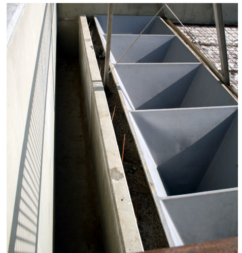
Mynd 6. Gildrur fyrir skít og fóðurleifar (Ljósmynd: Sören Jøker Trachsel).
