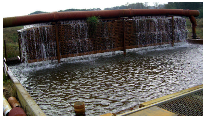
Mynd 32. Járn fjarlægt úr borholuvatni (Ljósmynd: Jóhann Geirsson).
