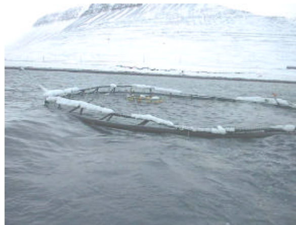
16. mynd. Ísing á hoppneti hefur brotið stangir sem eiga að halda netinu uppi (Mynd frá Hraðfrystihúsinu Gunnvöru hf.).
