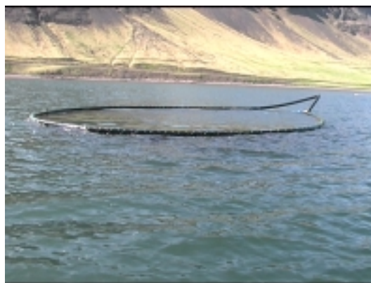
Mynd 2.16. Röralína í júní 2002 eftir línan hafði frosið í lagnaðarís.
