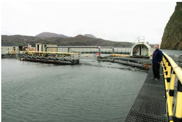
Mynd 6.9. Floteining með tveimur netpokum og tveimur húsum hjá Kví í Klettsvík í Vestmannaeyjum (Ljósmynd: Valdimar Ingi Gunnarsson).
