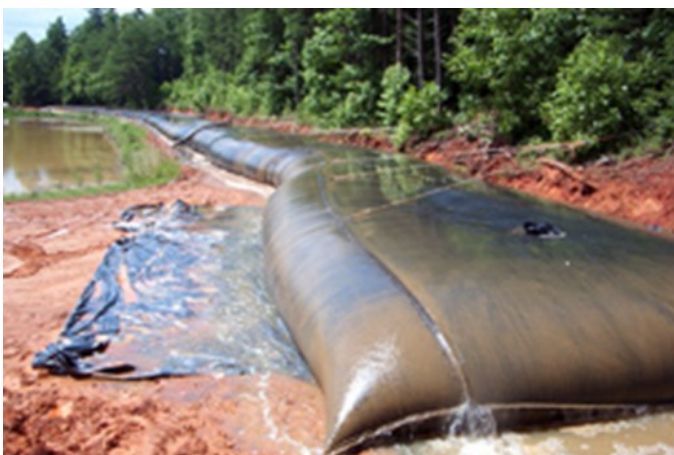
Mynd 10.11. Belgur úr gegndræpum jarðvegsdúk ( www.graniteenvironmental.com ).
