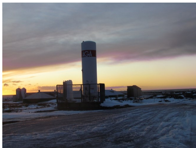
Mynd 6.30. Geymslutankur (Kæligeymir) með fljótandi súrefni (Ljósmynd: Guðmundur Einarsson).
