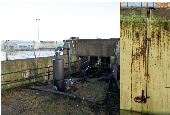
Mynd 6.41. Súrefniskeila hjá Íslandsbleikju á Vatnsleysu og til hægri á myndinni má sjá jektor (Ljósmynd: Valdimar Ingi Gunnarsson).
