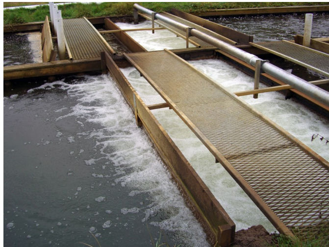
Mynd 6.14. Karaloftun í lengdarstraumskari í danskri landeldisstöð (Ljósmynd: Jóhann Geirsson).
