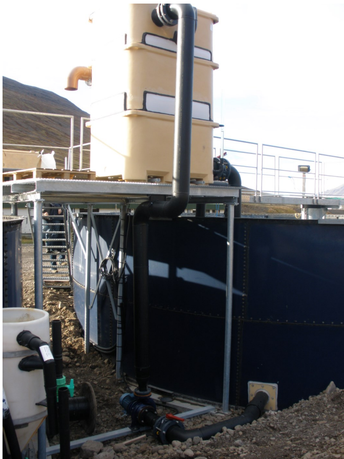
Mynd 6.29. Afloftari hjá Hólalaxi (Ljósmynd: Ingólfur Arnarson).
