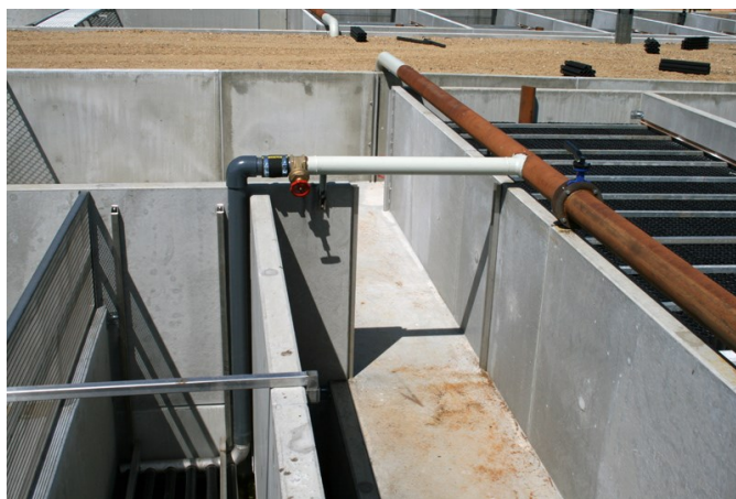
Mynd 6.10. Loftlagnir sem flytja andrúmsloft að loftdreifara (Ljósmynd: Søren Jøker Trachsel).
