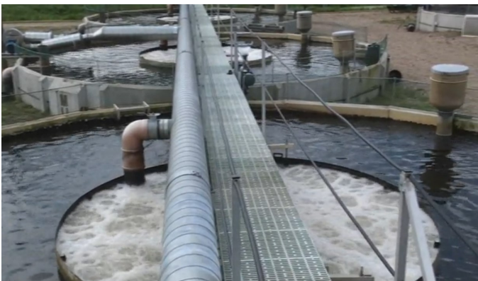
Mynd 6.12. Loftun fyrir miðju kari hjá Kærhede Dambrug í Danmörku. Á neðri myndinni sést ofan í loftarann ( www.youtube.com/watch?v=36MXyTfshFE ).
