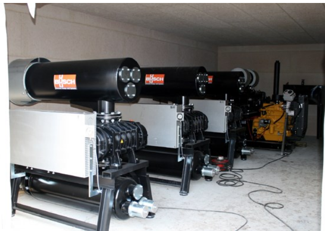
Mynd 6.9. Loftblásarar sem notaðir eru í dönskum landeðisstöðum með lengdarstraumskör (Ljósmynd: Søren Jøker Trachsel).
