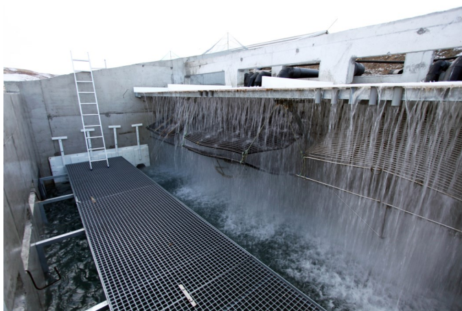
Mynd 6.25. Þyngdarafisloftari hjá Fiskeldinu Haukamýri (Ljósmynd: Valdimar Ingi Gunnarsson).
