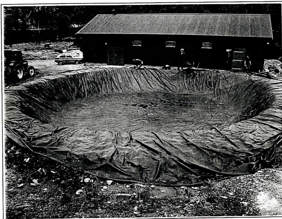
Mynd 9.3. Unnið við uppsetningu á dúklögðu kerri (Næss 1989).
